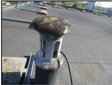
Photo N° 666 AMIANTE CIMENT -- Toiture terrasse Toiture Chapeau (Fibres-ciment)
