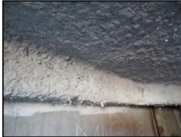
Photo N° 662 AMIANTE CIMENT -- LOCAL POUBELLE Conduits Ventilation haute (Fibres-ciment)
